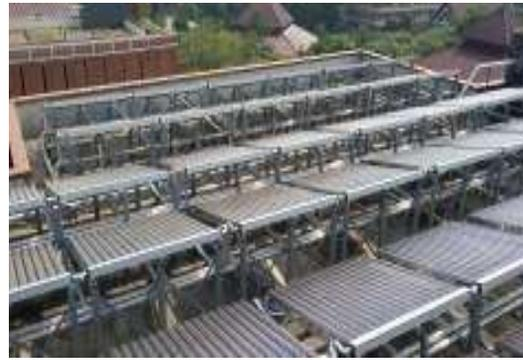
Gambar 2. Susunan tabung kolektor matahari di atap gedung perkantoran.
